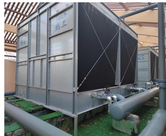
节水横流式中央空调冷却塔
