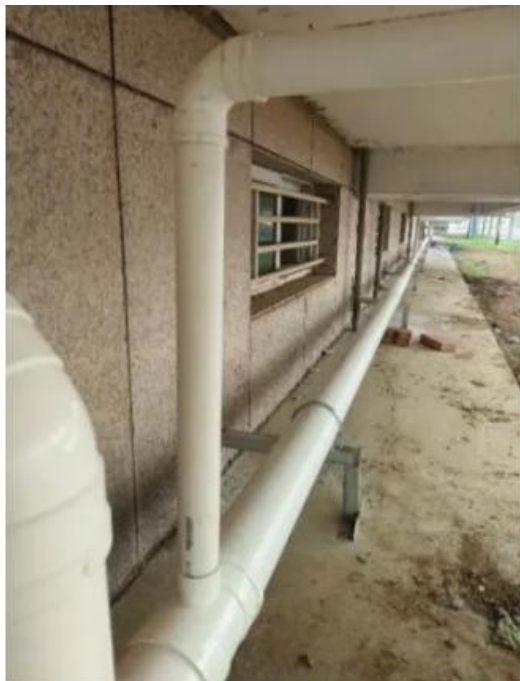
雨水、空调冷凝水收集利用系统
